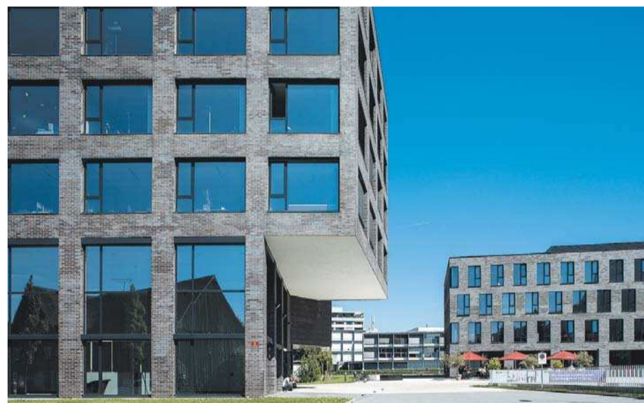
Der NTS-Standort in Dornbirn befindet sich im CAMPUS Gelände. Fotos: Prisma Holding, NTS
