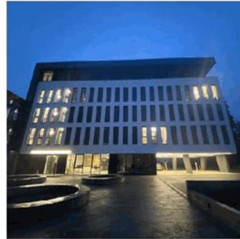
Nachtansicht der stark ausgebauten NTS-Zentrale in Raaba-Grambach INTS
